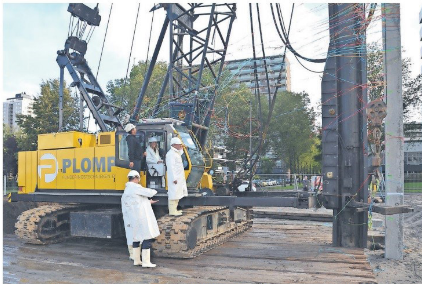
Nieuwe bewoonster Fay Vet slaat de eerste paal. Zij wordt bijgestaan door partner Jan Willem Goedknecht (niet zichtbaar op foto) en Ivo Zweekhorst, directeur van Kroon + de Koning. Wethouder Hans Versluis (rechts op de heistelling) volgt het proces. (Foto: Frans Assenberg)
